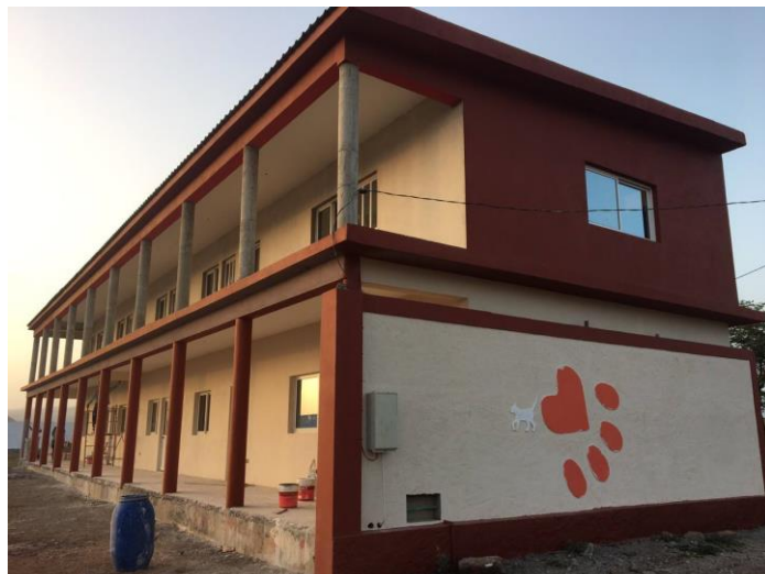
Gebäude im Bau
